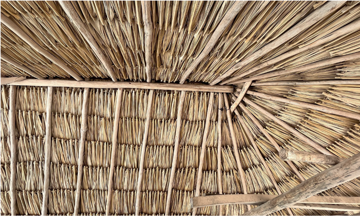
Palapa. Artesón construido con madera de zapotillo y guano. Foto: Karina Flores (2023)
